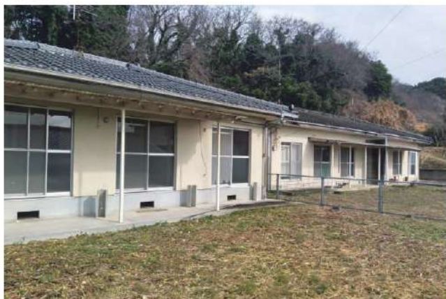
5棟全て空いている岱志高校職員宿舎
